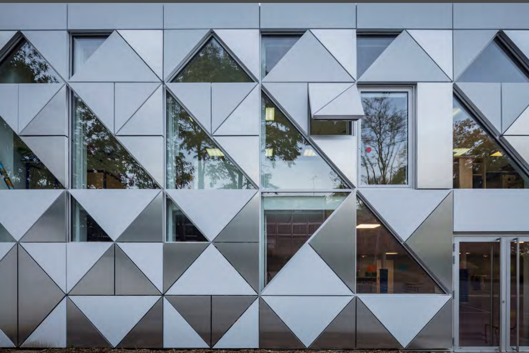
The mosaic of ALUCOBOND® elements in varying levels of reflection suggests a three-dimensional façade. Das Mosaik aus ALUCOBOND®-Elementen in unterschiedlichen Reflektionsgraden suggeriert eine dreidimensionale Fassade.
