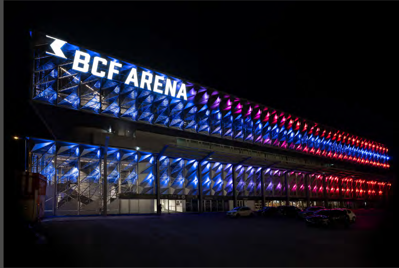
Light slots with LEDs in the façade profiles create a dramatic illumination of the three-dimensional ALUCOBOND® tray panels. | In den Fassadenprofilen erzeugen Lichtschlitze mit LED eine dramatische Ausleuchtung der dreidimensionalen ALUCOBOND®-Kassetten.
