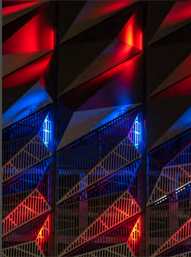
Light slots with LEDs in the façade profiles create a dramatic illumination of the three-dimensional ALUCOBOND® tray panels. | In den Fassadenprofilen erzeugen Lichtschlitze mit LED eine dramatische Ausleuchtung der dreidimensionalen ALUCOBOND®-Kassetten.
