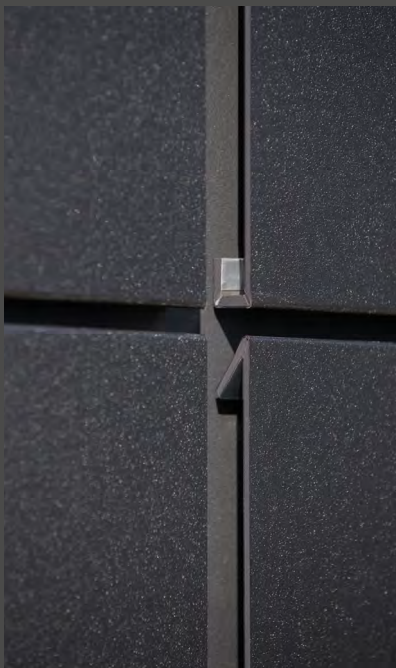
ALUCOBOND® easy fiX point-fixed on a wooden substructure. Installation from bottom to top. Mizu Boat shop, Architect Klaus Wetzstein. | ALUCOBOND® easy fiX punktuell auf Holzunterkonstruktion. Installation von unten nach oben.
