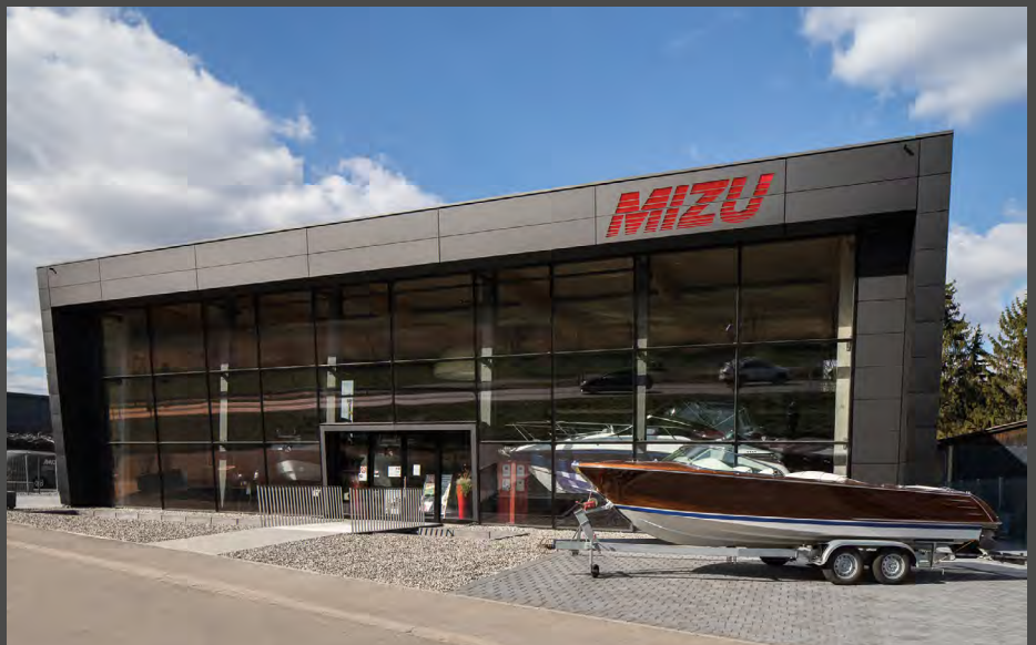
ALUCOBOND® easy fiX point-fixed on a wooden substructure. Installation from bottom to top. Mizu Boat shop, Architect Klaus Wetzstein. | ALUCOBOND® easy fiX punktuell auf Holzunterkonstruktion. Installation von unten nach oben.
