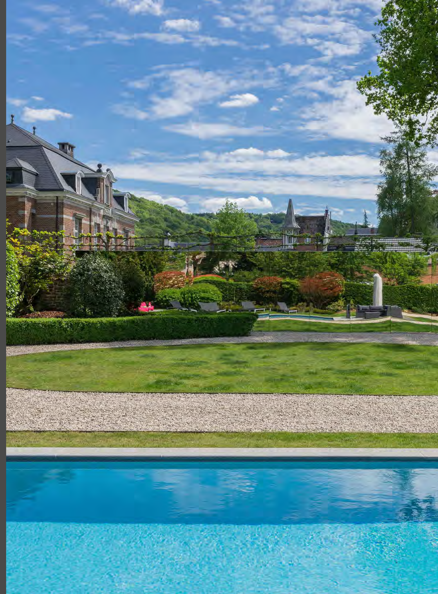
A garage, where?!! The glued on naturAL Reflect ALUCOBOND® panels make the building vanish into the landscape like a chameleon. | Garage, wo?! Die aufgeklebten ALUCOBOND®-Platten naturAL Reflect lassen das Gebäude wie ein Chamäleon in der Landschaft verschwinden.
