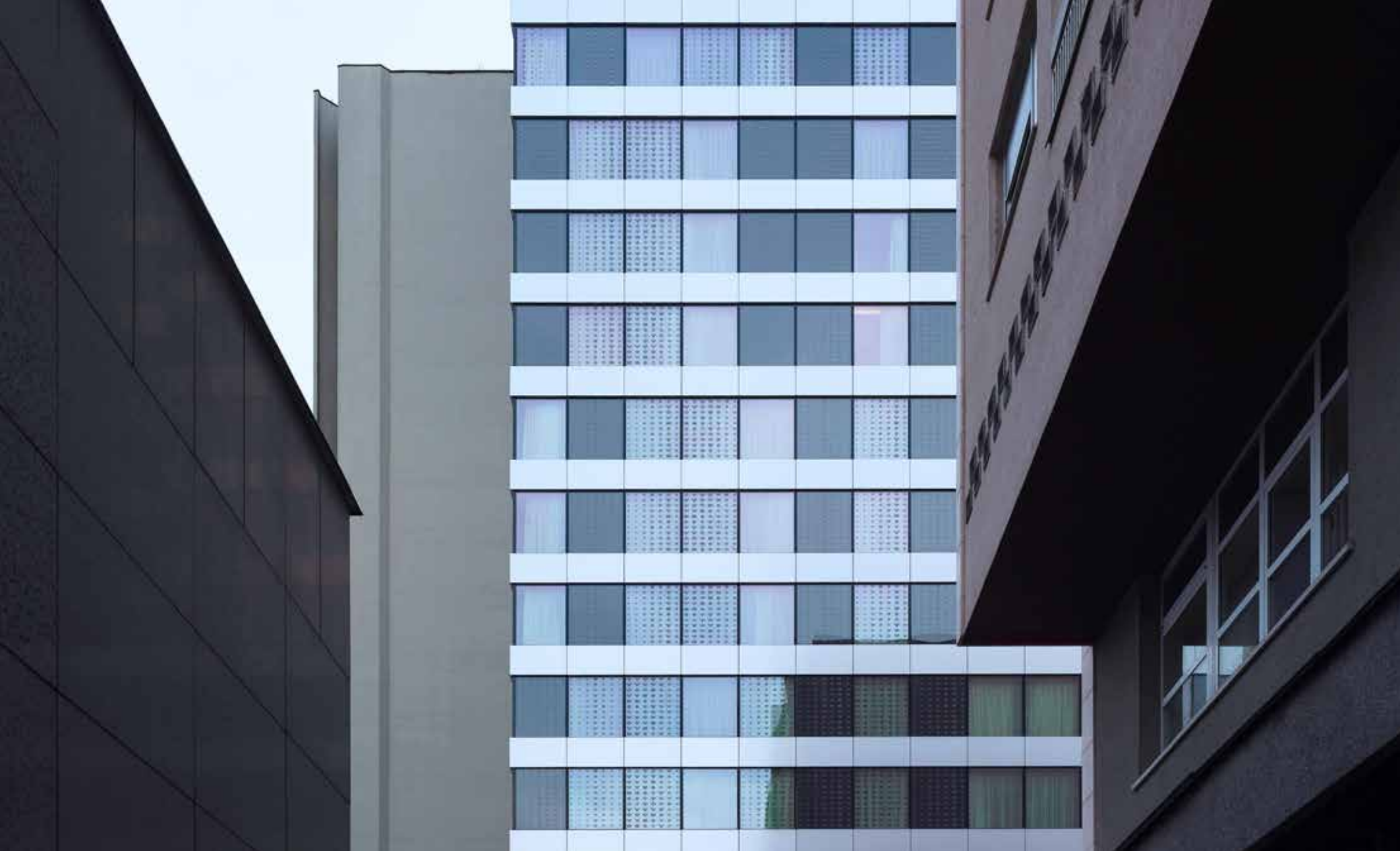
Typical, local motifs printed on the windows evolved from a standard dot matrix. Die Bedruckung der Fenster mit ortstypischen Ornamenten ist eine Weiterentwicklung eines herkömmlichen Punktrasters.
