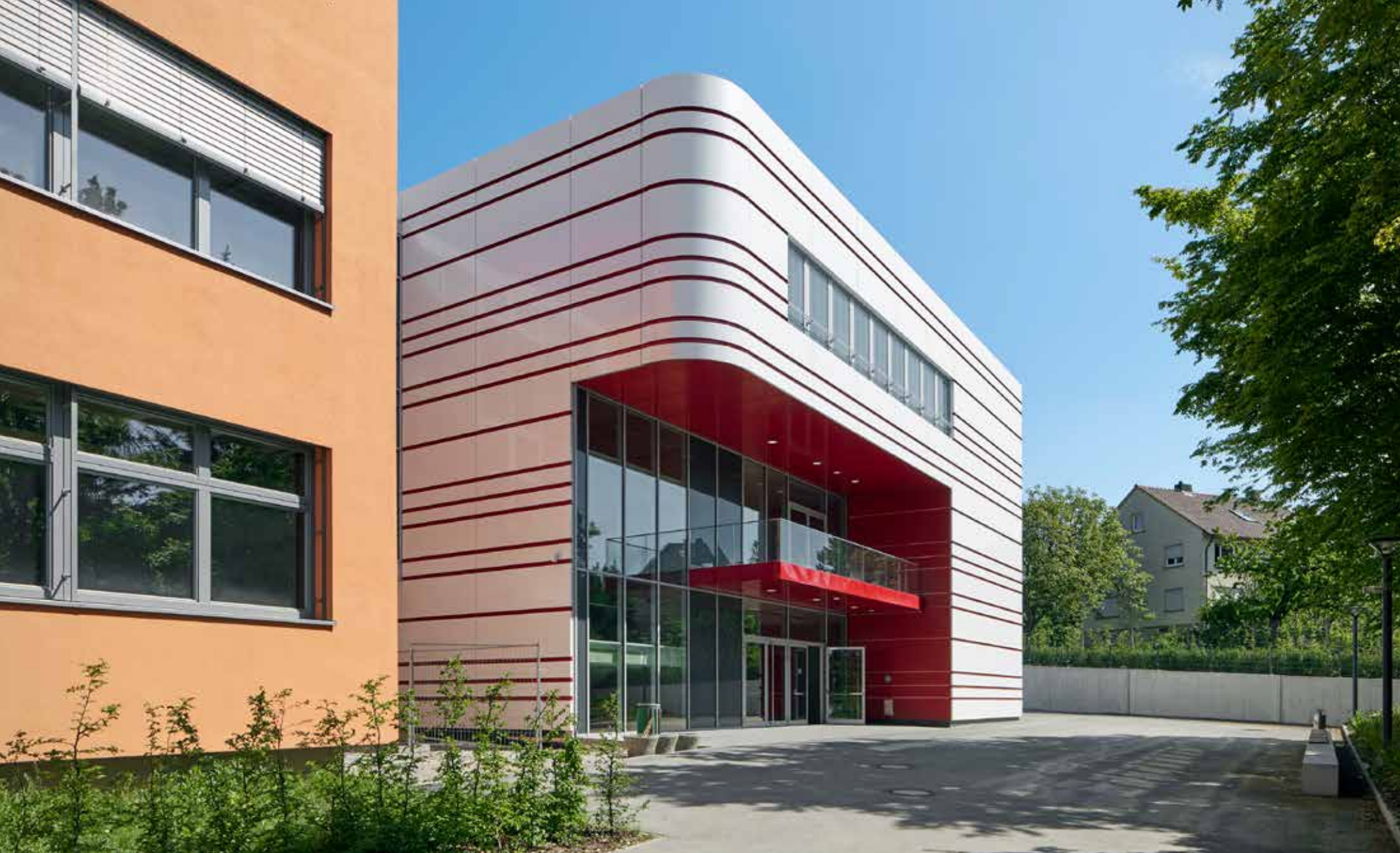
The building is at the edge of the school grounds, set back slightly but with an unmistakable entrance area. Das Gebäude bildet den hinteren Abschluss des Schulareals, leicht abgerückt, aber mit nicht übersehbarem Eingang.
