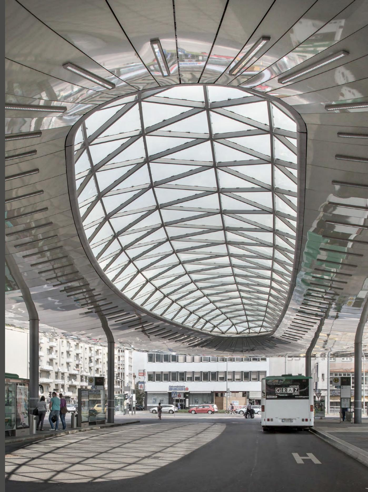
The underside of the roof is clad with curved ALUCOBOND® tray panels which reflect their surroundings upside down. In this way, the so-called "Golden Eye" conjures up a real-time overhead cinema with a retro look. | Die Dachunterseite ist mit gewölbten ALUCOBOND®-Kassetten verkleidet, die die Umgebung verkehrt herum reflektieren. Auf diese Weise zaubert das sogenannte „Golden Eye“ ein Echtzeit-Über-Kopf-Kino in Retro-Optik.
