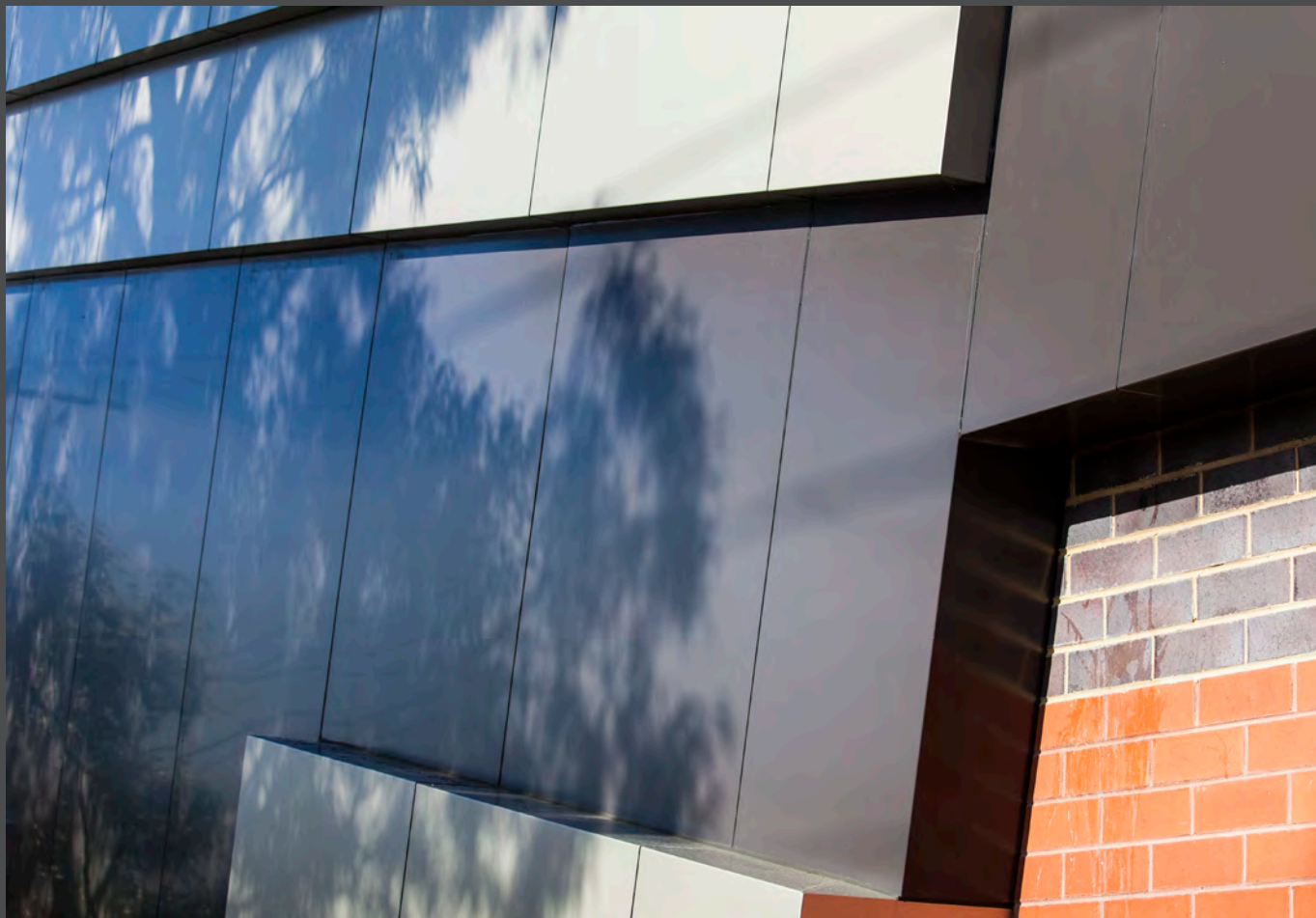
Transition between different cladding materials. Übergang verschiedener Fassadenmaterialien.
